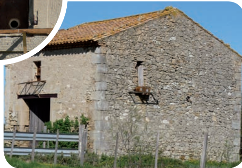
« Grangeot » nouvellement aménagé © A. Bonnot
