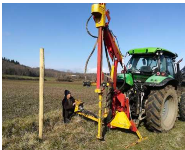
Photo du chantier de Nébias le 3 février 2021 - © Lise Dauverné
